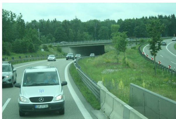
Extremos de Barreras metálicas semirrígidas, tomadas a Barreras Rígidas
