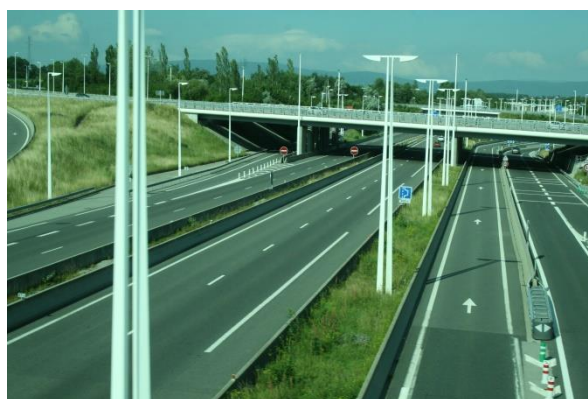
Esquema de medias Barreras rígidas de borde con espacio suficiente
