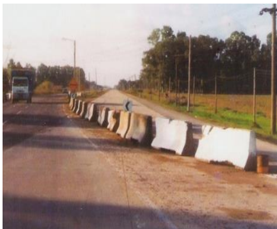
Emplazamiento irregular de módulos de barreras, a modo de delineador destinado a los usuarios del camino y esquema adecuado como protector del personal y equipos que operan en la obra vial
