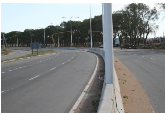
Barrera Rígida unitaria central, la cual denota las dificultades de instalación de columnas de iluminación o de sistemas de señalización.
