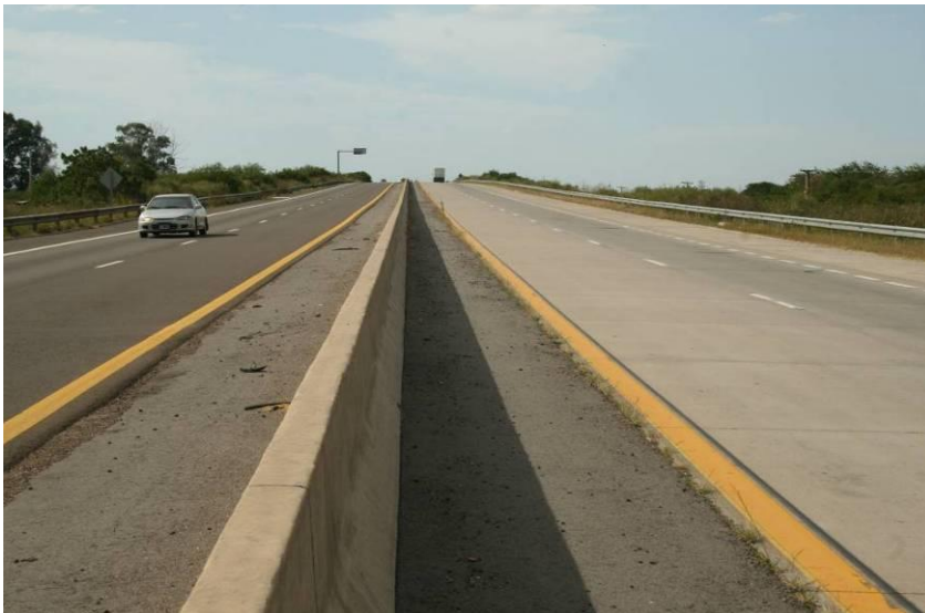
Barrera rígida instalada en la Ruta Nacional 14 “Autovía José Gervasio Artigas” en jurisdicción de la Prov. de Entre Ríos.
