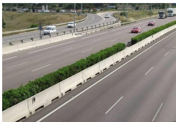
Barrera Rígida unitaria central, la cual denota las dificultades de instalación de columnas de iluminación o de sistemas de señalización.
