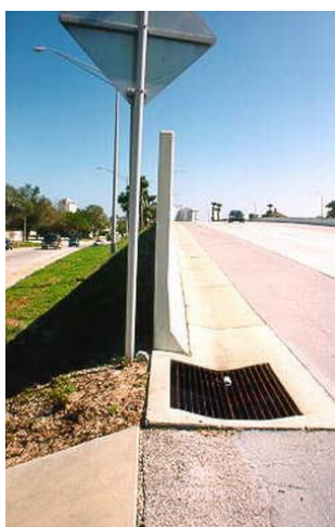
Borde tipo cuneta, para canalizar hacia las bocas de desagüe, el agua proveniente de las lluvias
